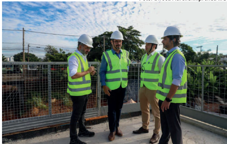
O vice-governador Mateus Simões vistoriou, nesta quinta-feira (20/3), o avanço das obras de construção na futura estação Amazonas, que integra a nova Linha 2.
