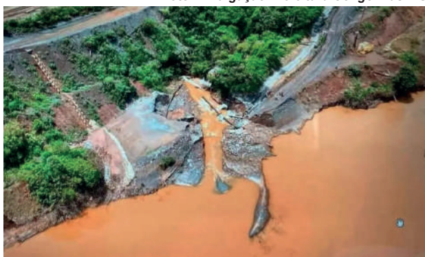
Vazamento de sedimentos da Vale em Congonhas impacta o Rio Maranhão e causa graves danos ambientais.
